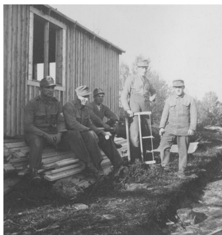
Tischler und Zimmerleute bauen Baracken aus!
